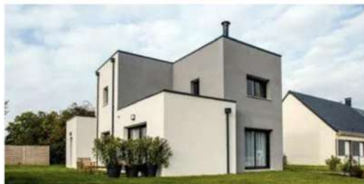
Les logements sont dans un petit bâtiment
